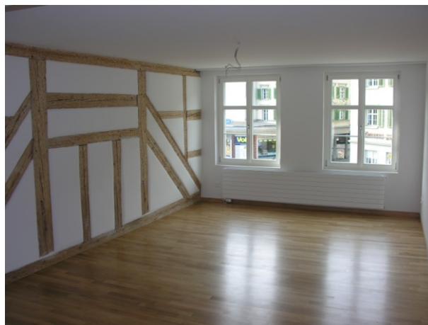
Gemeindelienschaft „Postgebäude“: Wohnzimmer vor Umbau (links) und nach Umbau (rechts) – unter anderem konnten verschiedene alte Riegel freigelegt werden.
