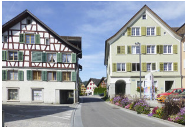
Referenzbeispiel: Neugestaltung der Dorfstrasse und des Kirchplatzes in Thal SG
